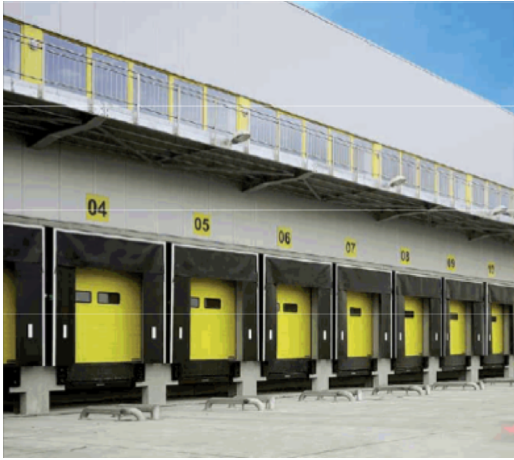
Vista exterior muelles de carga
